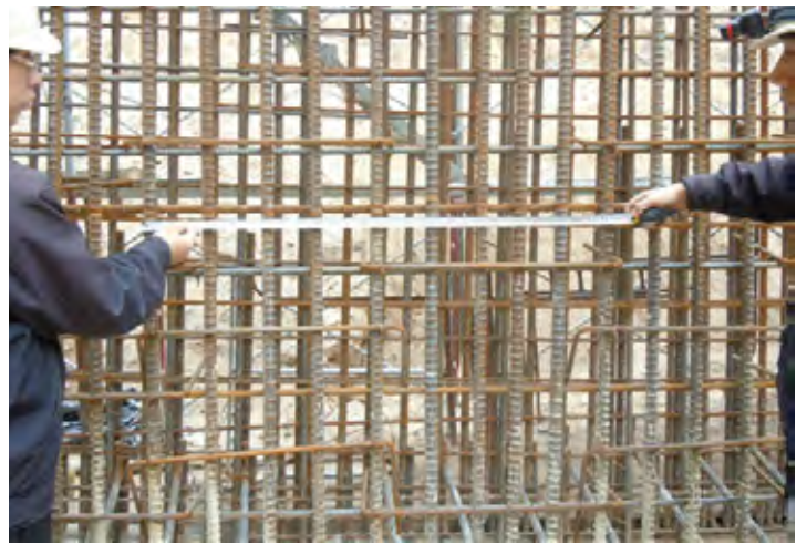
충남신도시 지하차도 정기안전점검 및 초기점검
